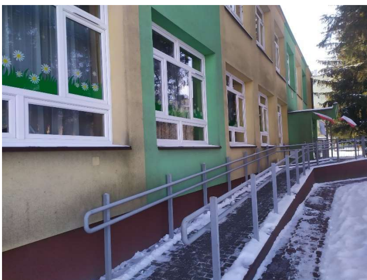
Zdjęcie przedstawiające wejście dla osób niepełnosprawnych budynek główny ul. Piotra Skargi 15
