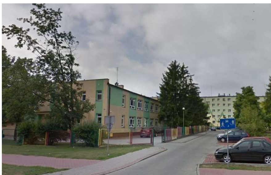
Zdjęcie przedstawiające budynek główny przedszkola
