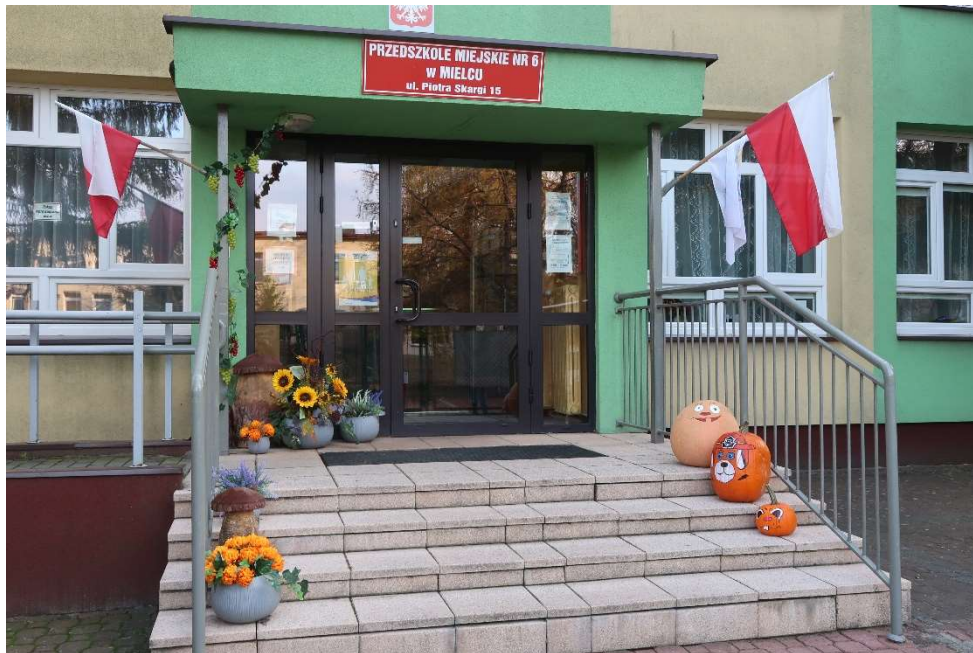
Budynek przedszkola widok od strony wejścia
